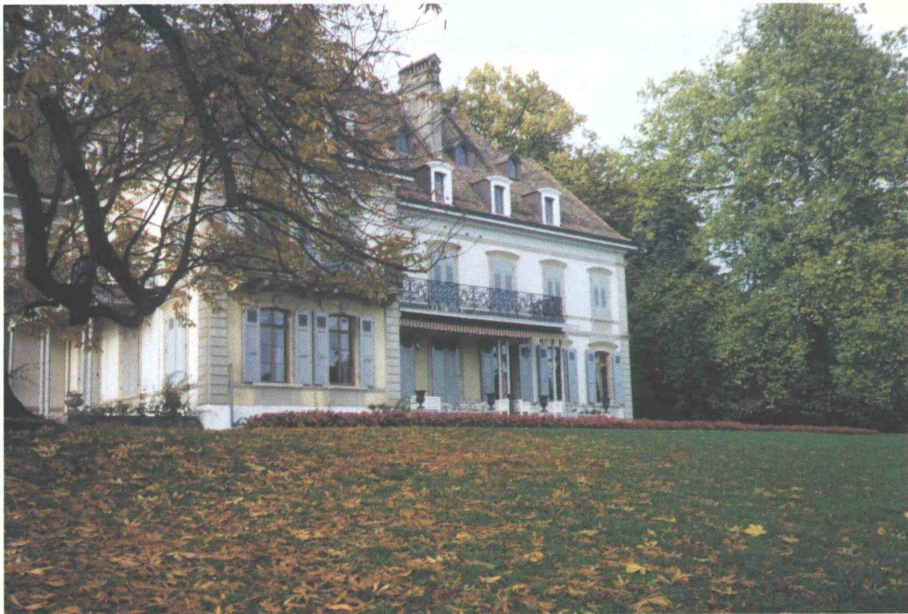
Château des Créneés, à Mies
