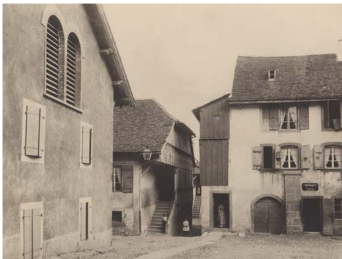
Épicerie de la Ruelle du Petit Port
