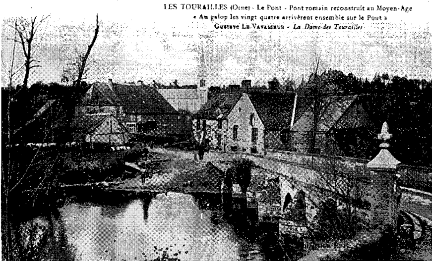
L'ancien pont traversant La Rouvre
