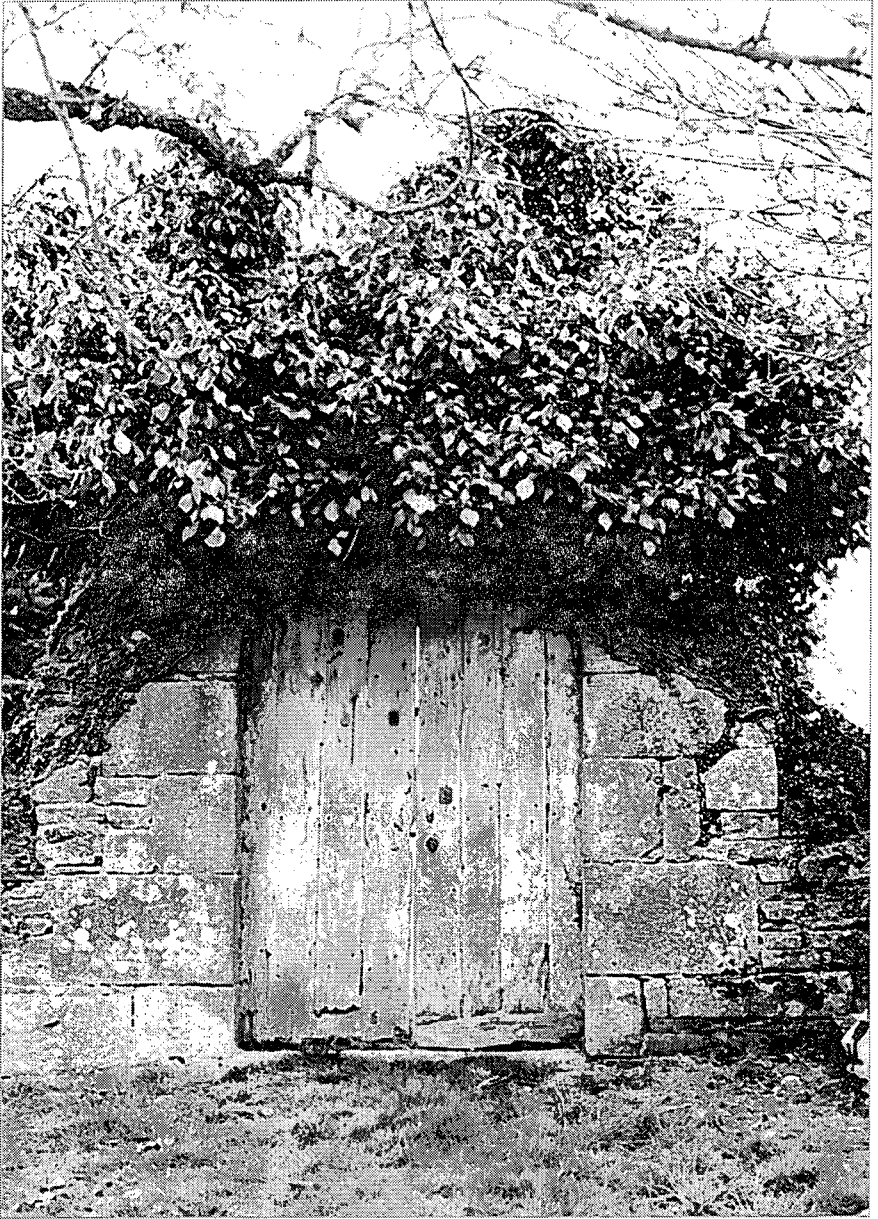
La porte du temple de La Torrière construit en 1805, détruit en 1871, en remplacement d'un autre bâti vers 1620, démoli en 1680 141
