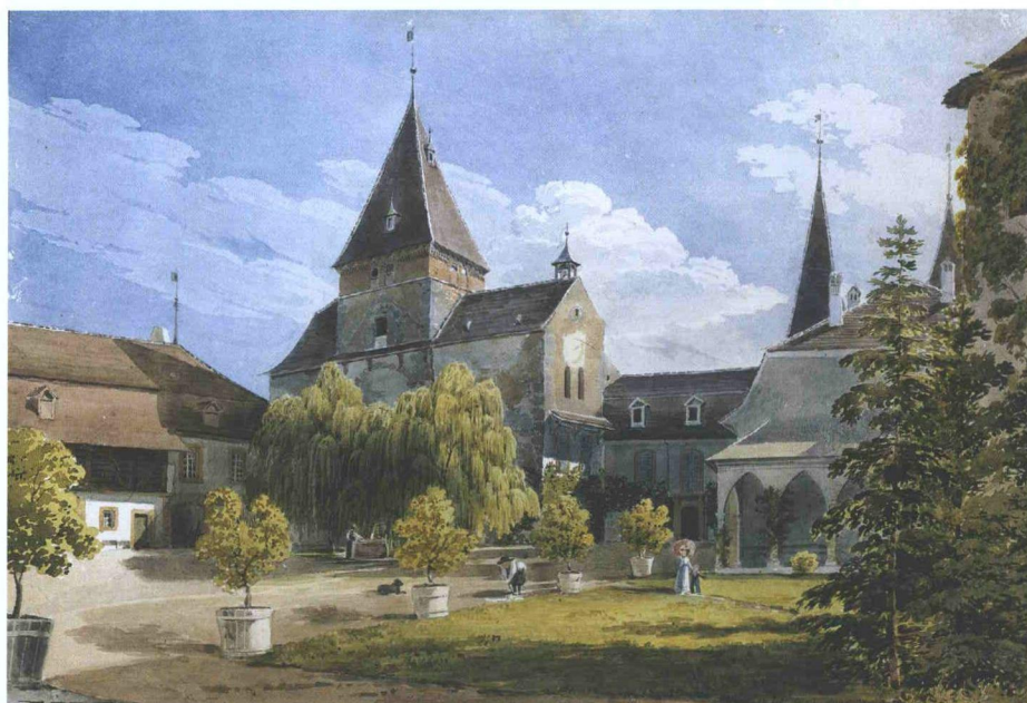
Schloss Münchenwiler. Blick in den einstigen Wirtschaftshof, der auch als Hauptauffahrt diente. Links die 1812 erbaute und um 1850 bereits wieder abgebrochene grosse Schlossebene, rechts das neugotische, um 1820 errichtete Peristyl. Die Ökonomiegebäude im Schlossbereich störten die Besitzer mehr und mehr, denn sie entsprachen nicht mehr der Vorstellung von einem vornehmen Landsitz. Um 1850 wurden sämtliche Landwirtschaftsbereiche in neue, ausserhalb der Schlossparzelle angesiedelte Gebäude verlagert. Jacques Henri Juillerat (1777–1860) zugeschrieben, Aquarell, um 1820.
