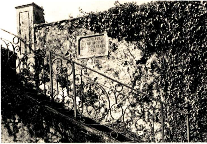
Escalier donnant accès au parterre du Reposoir, cadeau de Jean Lullin à son beau-frère Isaac Pictet, 1779.
