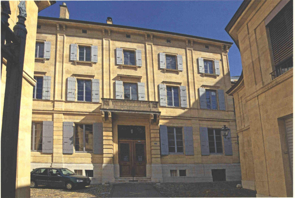
Faubourg de l'Hôpital 18, façade côté cour.
